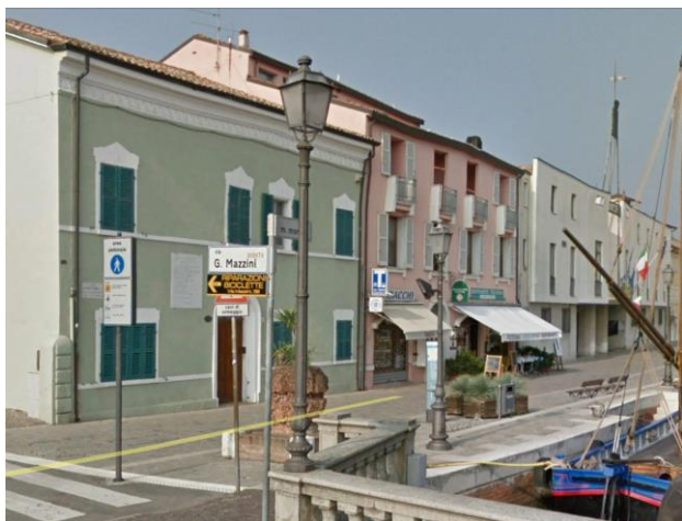
Foto cortina oggetto d'intervento - ANTE
